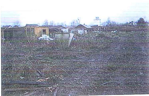
Im Rahmen der Baufeldfreimachung wurden die kontaminierten Materialien kontrolliert ausgebaut, bzw. separiert und verschiedenen Entsorgungswegen zugeleitet.
